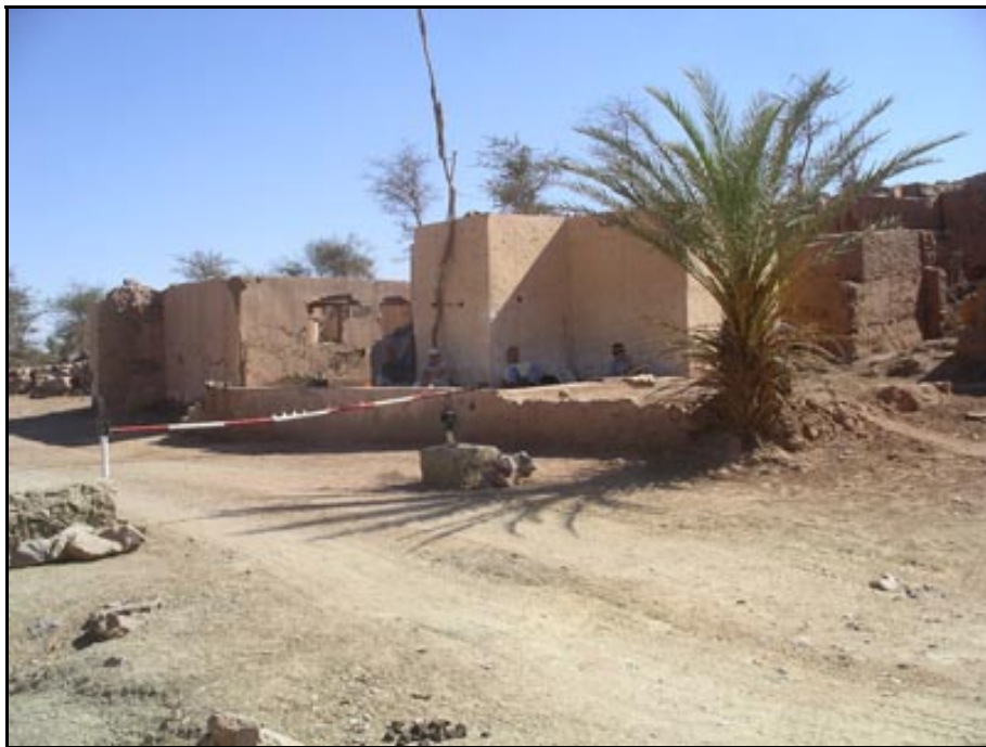
Le poste de la passe de Twisgui Remz
