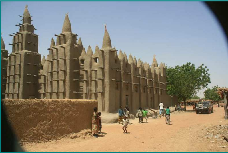
Dans un village, copie revisitée de la mosquée de Djenné
