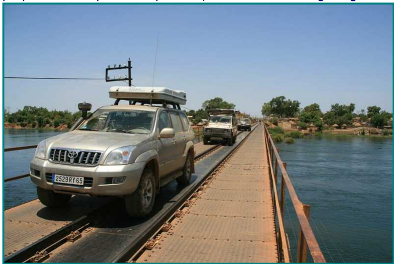
Traversée du Bafing sur le pont de chemin de fer de Mahina.
